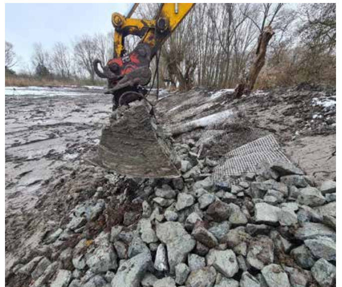
Ufersicherung mit Wasserbausteinen
