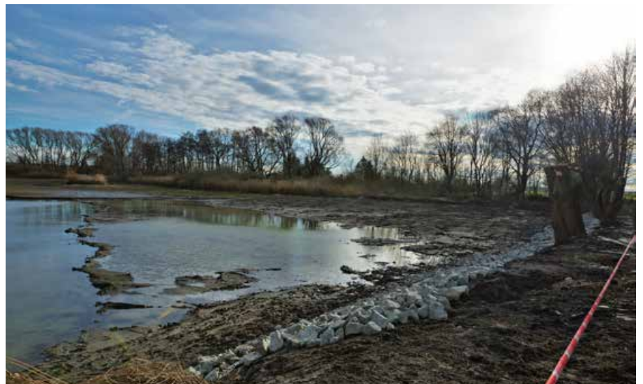
Krautteich - entschlammt Bereich mit gesicherter Böschung
