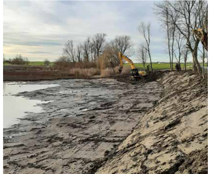
Abschluss der Baggerarbeiten am Pehritzscher Teich
